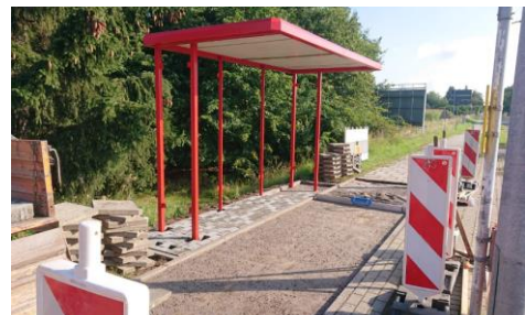
Neubau Bushaltestelle Hoyerswerda Straße
