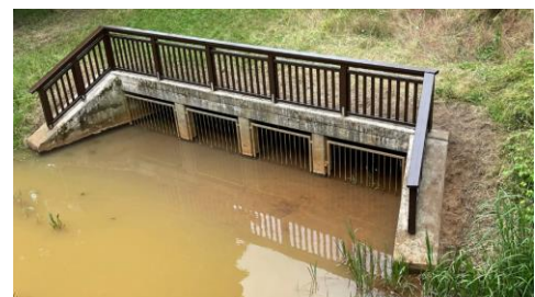
Geländer am Einlauf Liebesinsel
