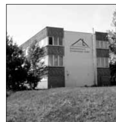
Im Haus der NBL - Gebäudeservice
