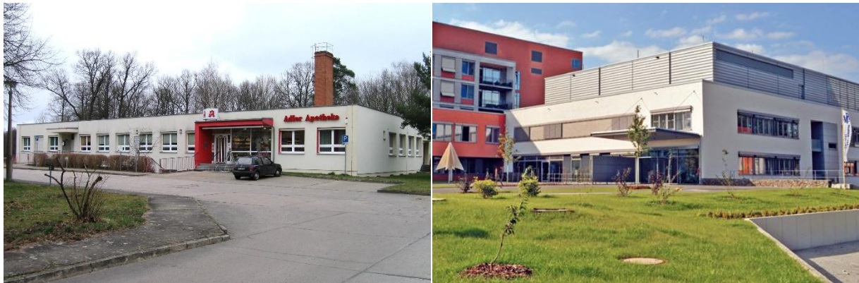
Abb. 21 Ärztehaus Altdöbern (links) und Krankenhaus Spremberg, Teilansicht (rechts, Bildquelle: Spremberger Krankenhaus GmbH)
