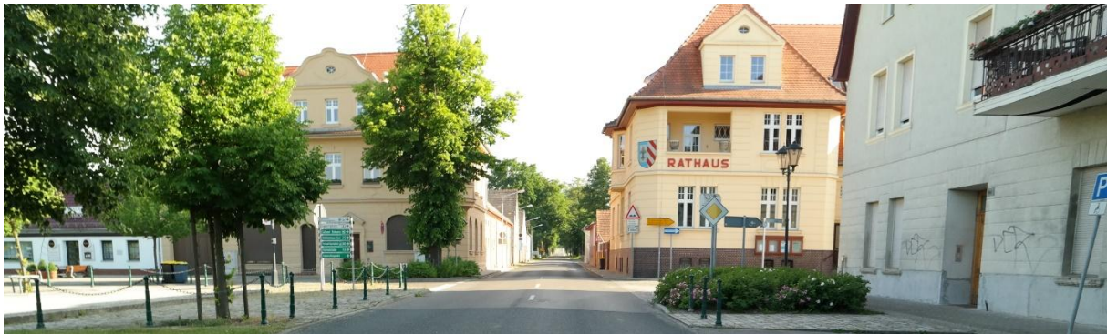
Abb. 30 Verwaltungsgebäude in Altdöbern — Hier besteht Anpassungsbedarf zur Herstellung der Barrierefreiheit
