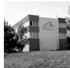
Im Haus der NBL- Gebäudeservice
