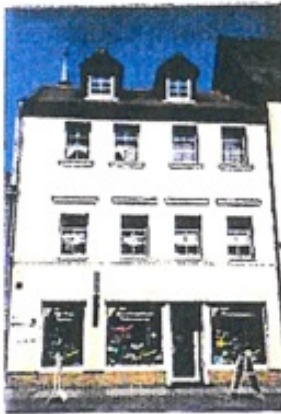
Sattelgauben, Lange Straße
