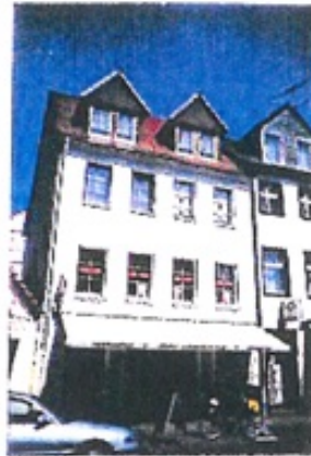
Sattelgauben, Lange Straße
