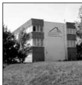
Im Haus der NBL - Gebäudeservice
