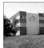
Im Haus der NBL - Gebäudeservice
