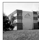
Im Haus der NBL - Gebäudeservice
